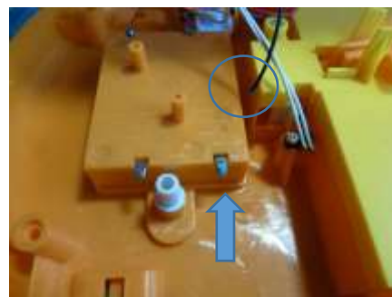
写真②(断線ヶ所)
